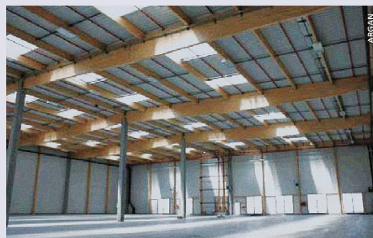
Site conçu par Argan pour l'Oréal à Roye (80). L'éclairage naturel a été fortement renforcé et la structure est mixte béton/bois
