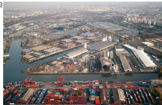
Le Port de Gennevilliers. Ports de Paris voit son trafic global et conteneurisé en hausse en 2010
