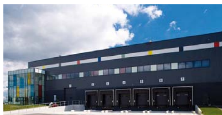
Bâtiment Paul Hartmann S.A à Belleville (Rhône)
